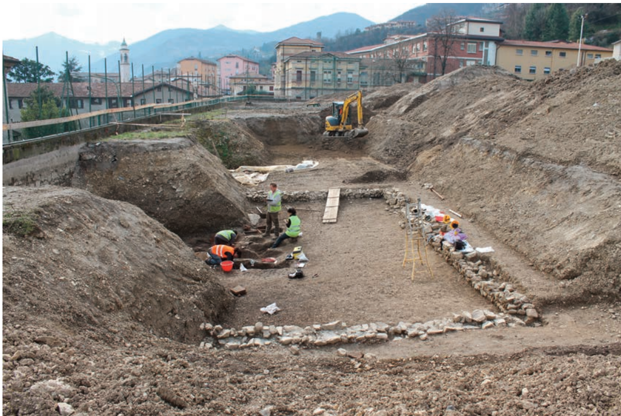
Fig. 3. Panoramica generale dei lavori.
