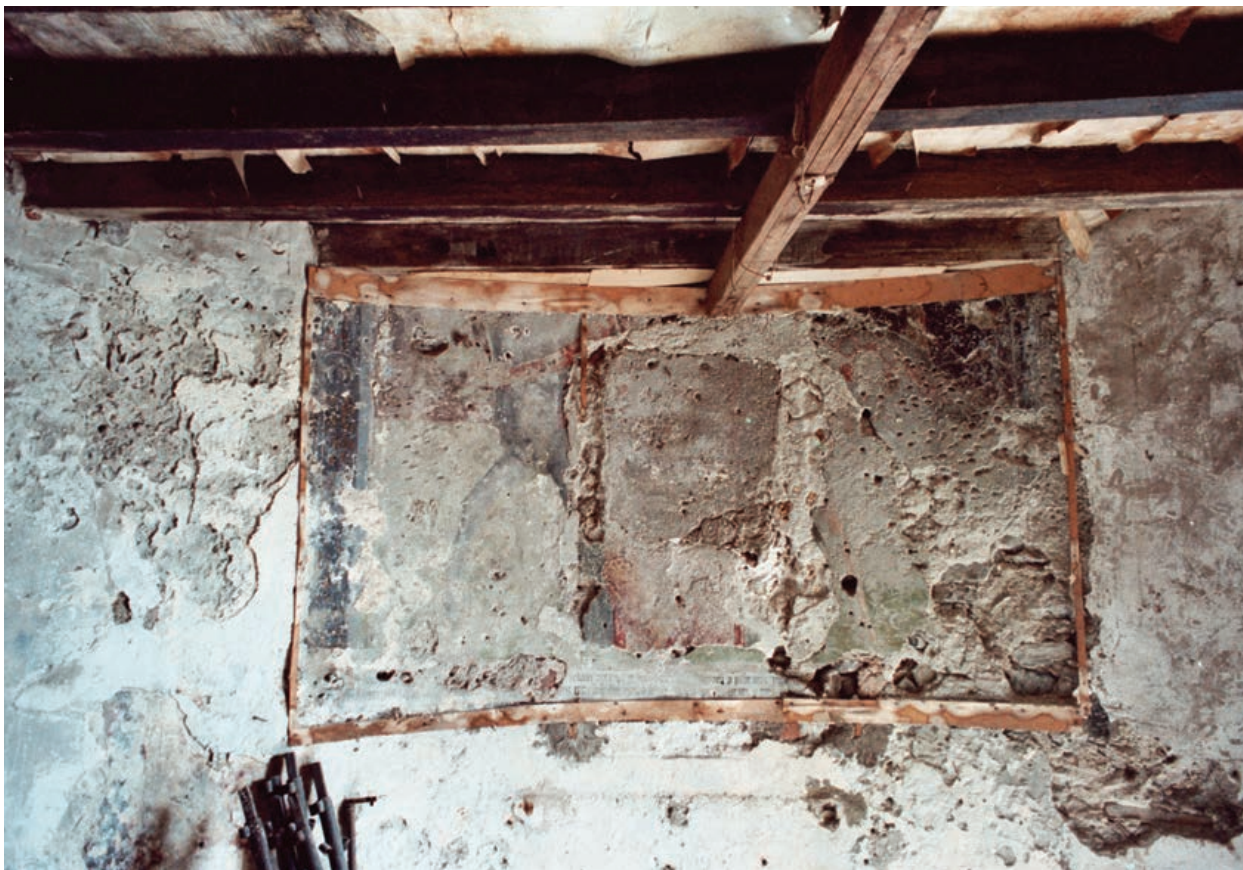
Fig. 6. Lovere, San Martino. Abside durante i lavori di restauro (foto di Luigi Cottinelli, cortesia di Andrea Breda).
