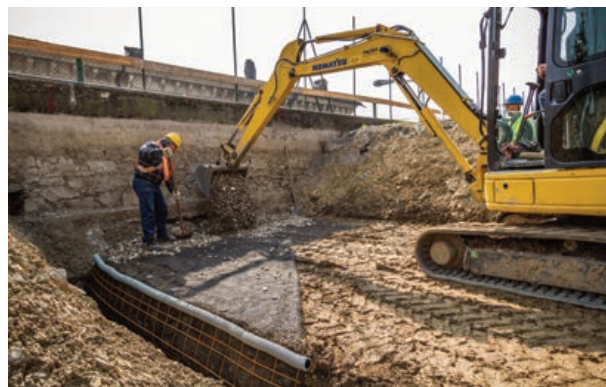
Fig. 14. Tecnica delle terre armate (Foto D. Bassanesi).
