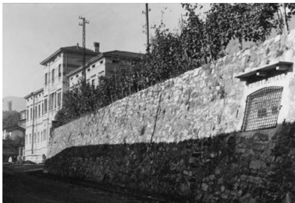
Fig. 8. 1957 - Muro rifatto dopo crollo parziale con grata inserita.
