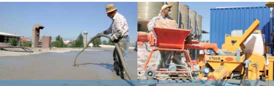
Pompaggio di cemento cellulare
