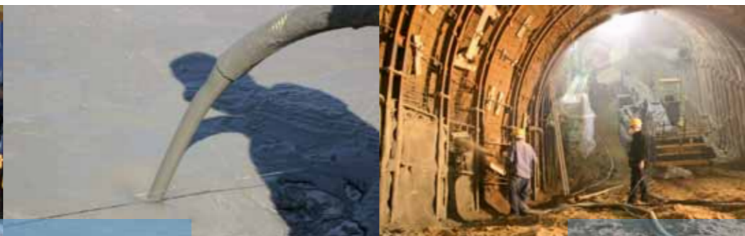
Pompaggio di cemento cellulare
