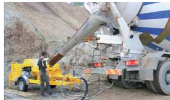
alimentata da un'autobetoniera
