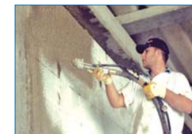
Spruzzatura di intonaco
