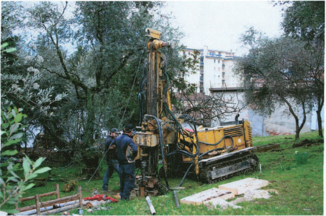
Foto 1- Attrezzatura utilizzata per esecuzione dei sondaggi geognostici
