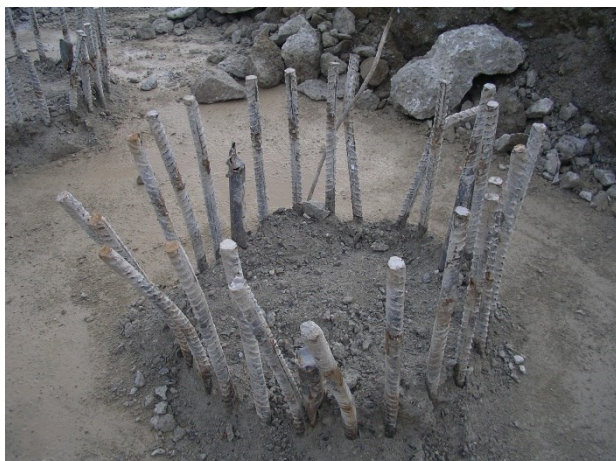
Fig. 5.3.a Realizzazione di pali trivellati di grande diametro
