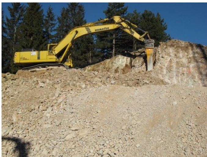
Figura 5.1: scavo in un pendio.
