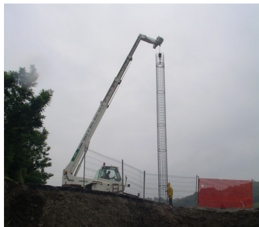
Fig. 5.3.b inserimento della gabbia di armatura del palo
