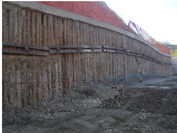
Figura 5.2: realizzazione di micropali
