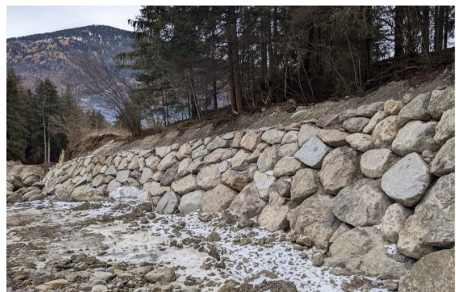
Figura 10: Esempio scogliera di protezione.
