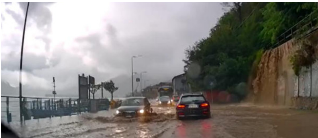
Figura 4: Via Marconi; l'acqua straripata dall'alveo a monte, arriva sino a lago.
