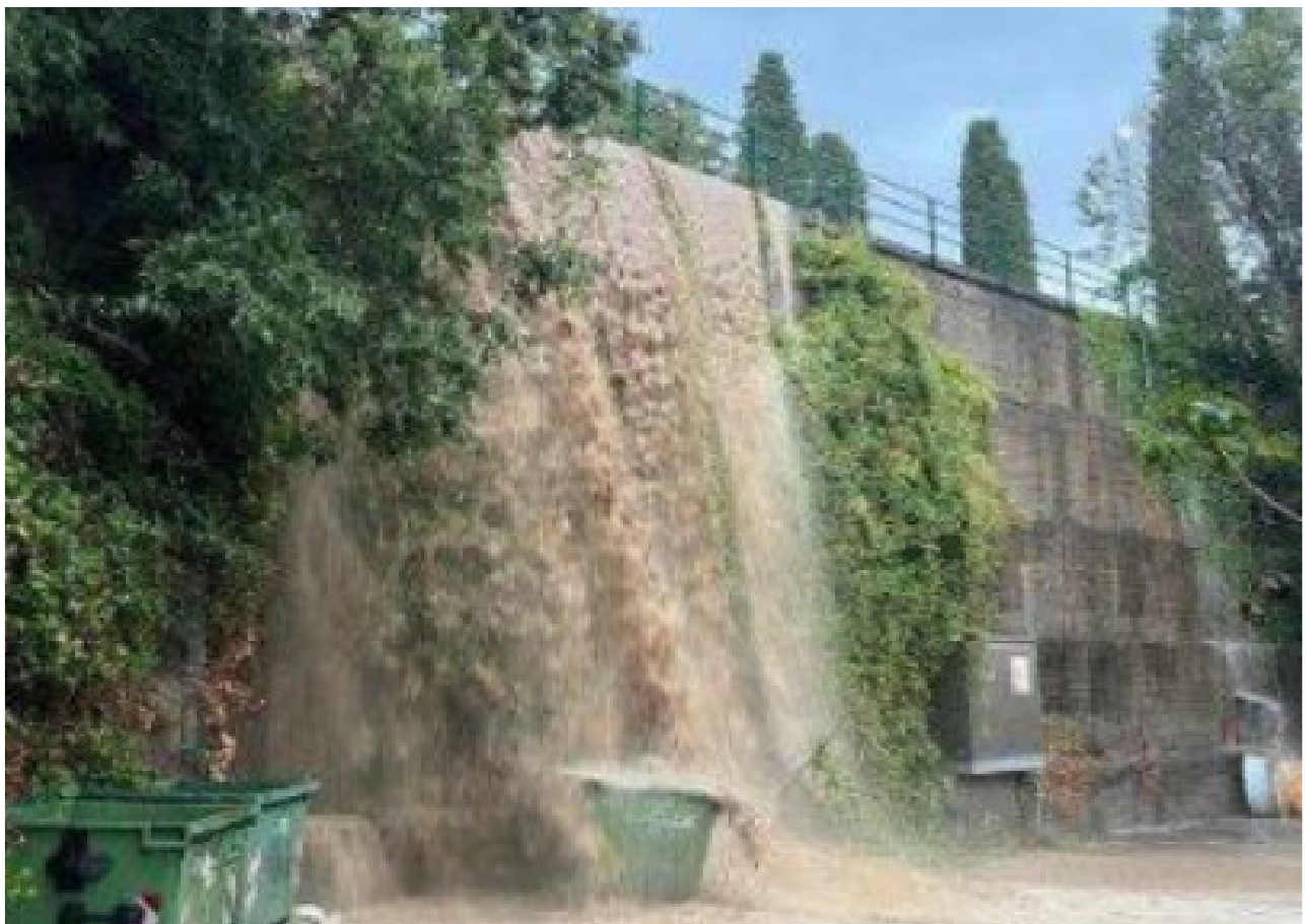
Figura 3: Scarpata a valle del piazzale del cimitero dove la portata di piene tende a riversarsi e a proseguire il suo percorso.
